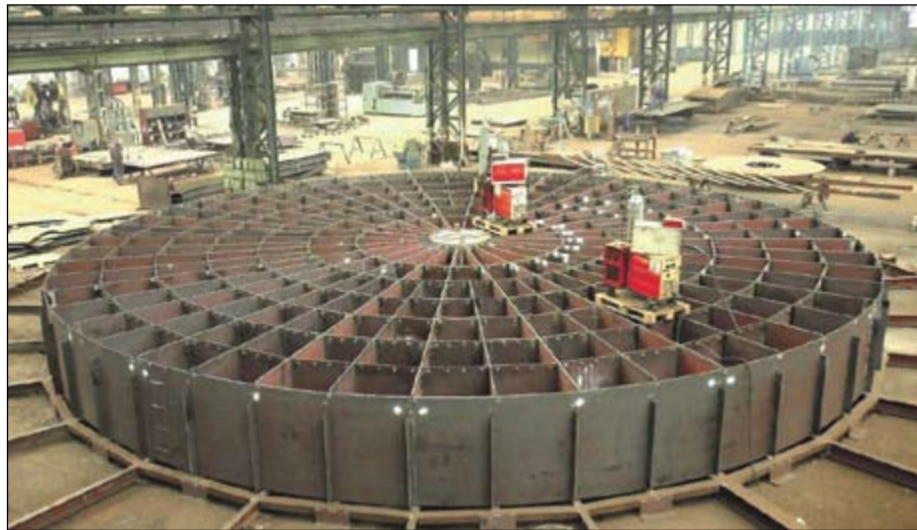
Rotor w końcowej fazie montażowej
